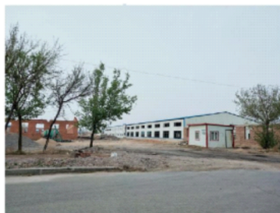
项目北侧在建企业
